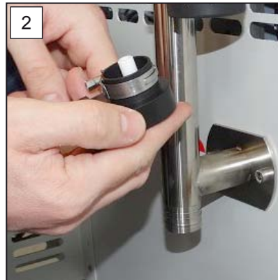
2. Stecken Sie die Schlauchschelle D32 über den Kondensat-Anschluss.
