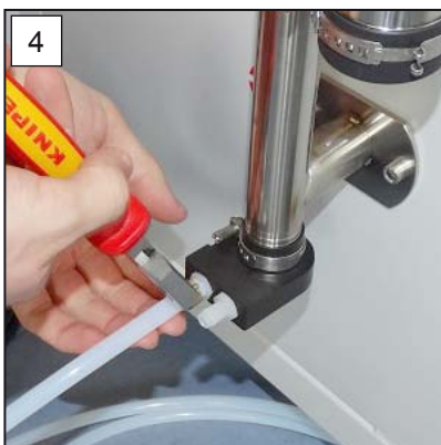
4. Schieben Sie die Schläuche auf die Schlauchwellen des Kondensat-Anschlusses.
