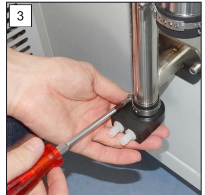
3. Stecken Sie den Kondensat-Anschluss auf das Abgasrohr und fixieren Sie die Schlauchschelle D32 mit einem Kreuzschlitzschraubendreher Gr. 2.
